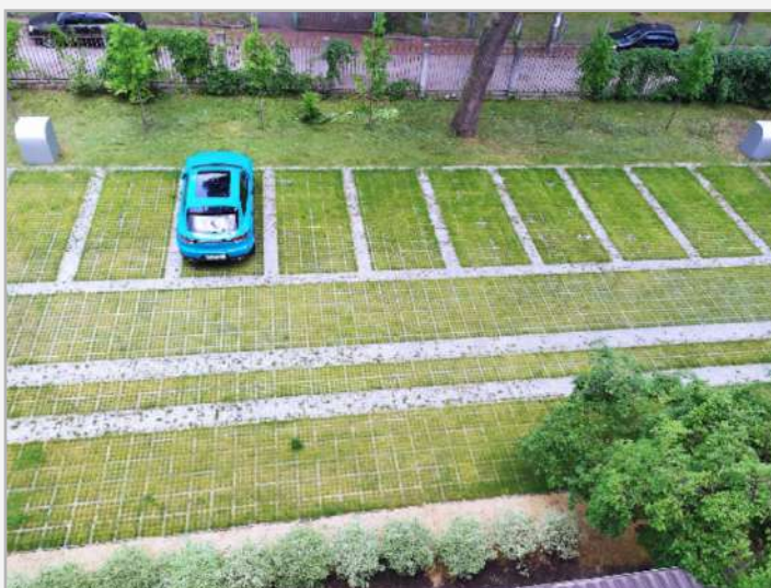
Рисунок 66: Паркування, облаштоване покриттям, що дозволяє стік дощової води до ґрунту (т.з. «Зелене» паркування), готель, Київ
